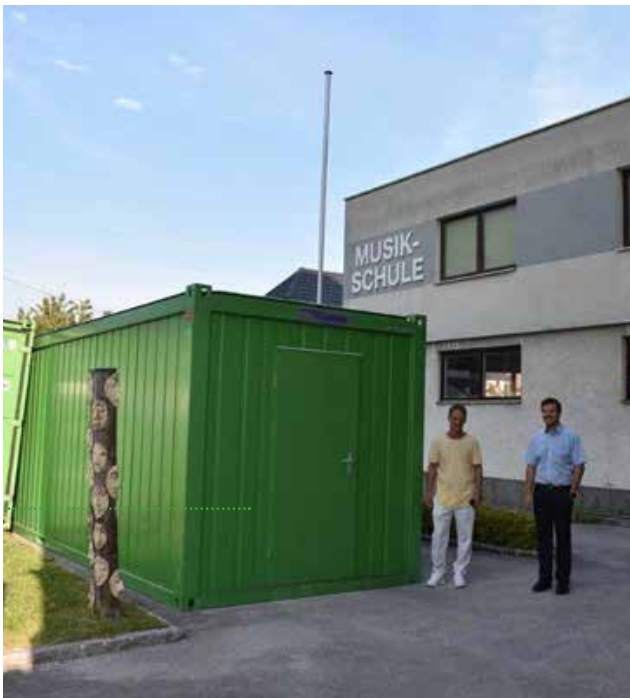
Endlich geht es los: GF Fölsner und Bgm. Gangl machen sich persönlich ein Bild über die Baustelleneinrichtung beim Projekt "neuer Turnsaal MS"
