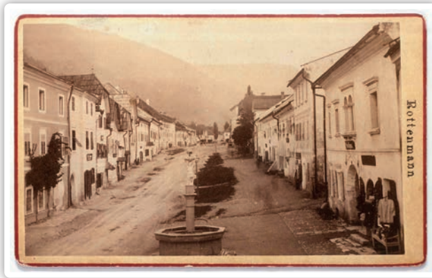
Die untere Hauptstraße mit dem „Stadtbrunn Nr. IV“
