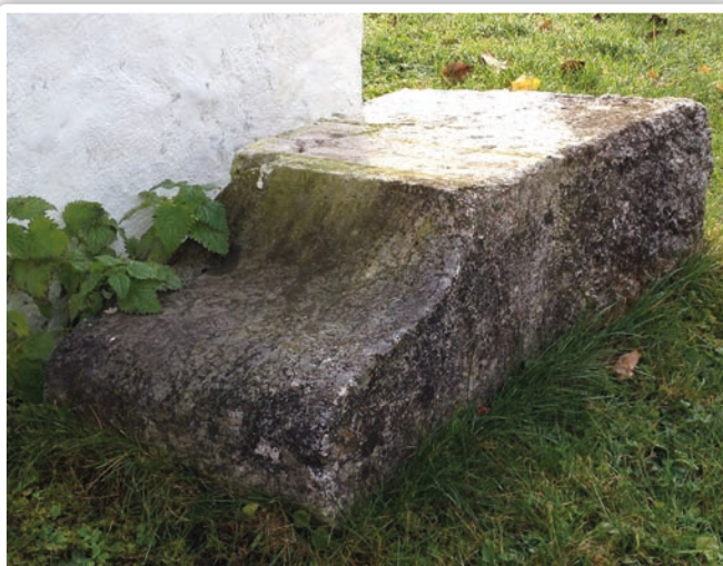
Ein unscheinbares Relikt liegt („auf den Kopf gelegt“) im Ploder-Garten – Einer jener beiden Kragsteine, auf denen der Erker des Rathauses befestigt war. Aufgefunden von Fritz Ploder sen., als im Jahr 1968 die Geschäftsräume im Haus umgebaut wurden.
