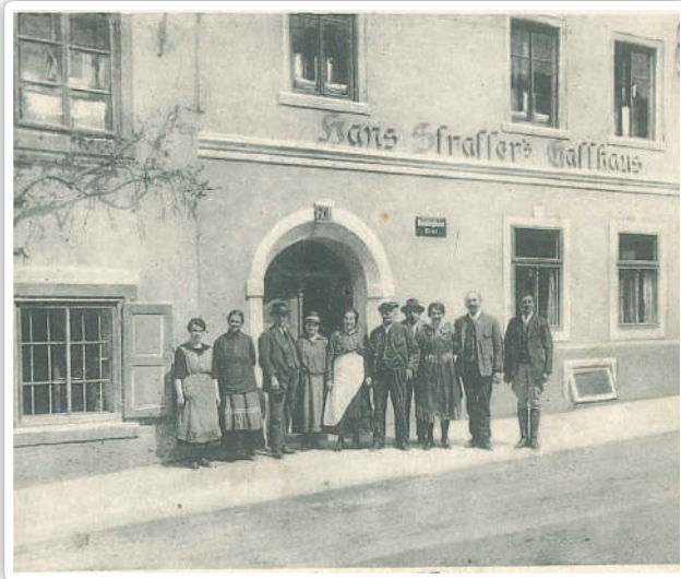
Gasthaus des Hans Strasser um 1920, damals bereits „Hauptstraße 76“
