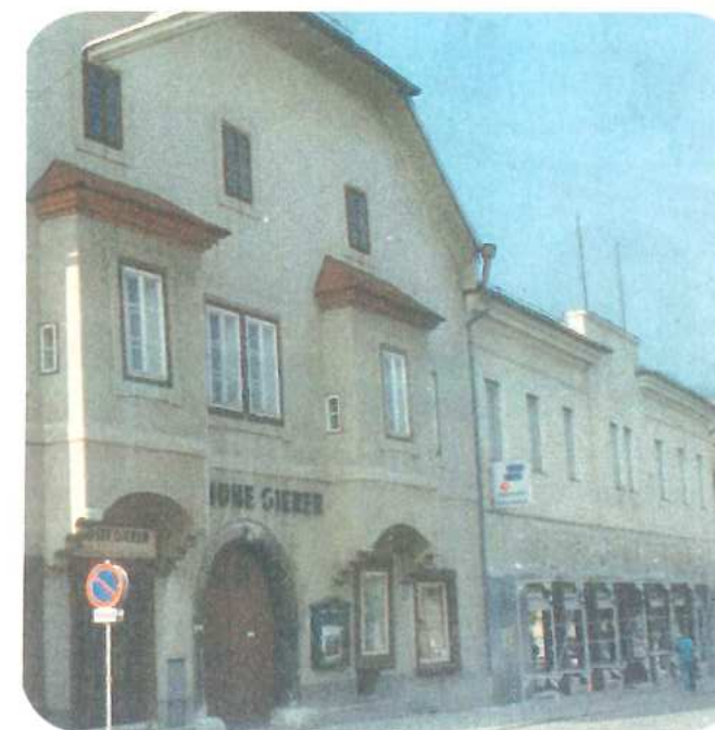
Bild vom Umbau seitens der hierher gesiedelten Firma Matschweiger
