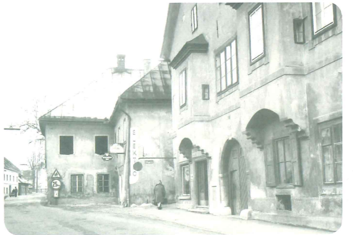
Ansicht kurz vor dem Abbruch des Hauses Hollerer
