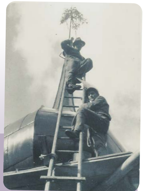
August Gretler mit Gehilfen bei den Spenglerarbeiten am Turm der Sankt Georgener Kirche.
