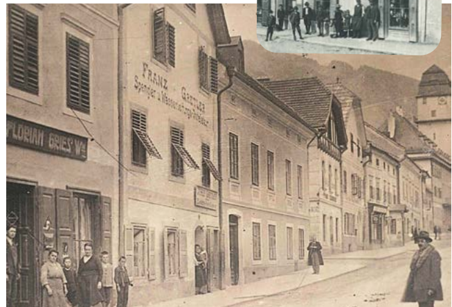
Um 1920 hatte auch noch der Elektromeister Josef Grebler als „Elektro-Installateur“ seinen Firmensitz im Haus.
