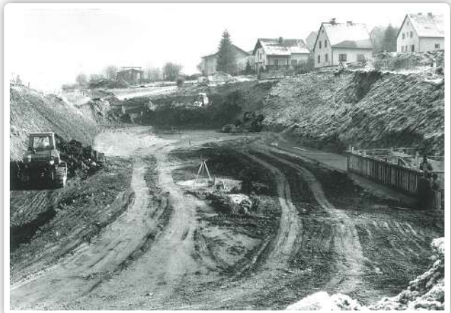
Die Unterflurtrasse der Autobahn wird gebaut
