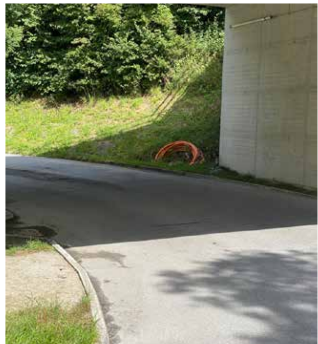
Neue Lichtwellenleiter werden verlegt
