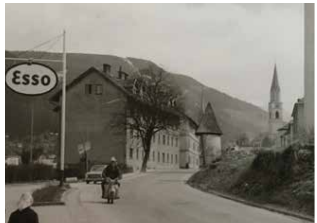
Westlich des Hochhauses wurden Ende der 1960er-Jahre die Siedlungshäuser nahe der Pestkapelle errichtet.
