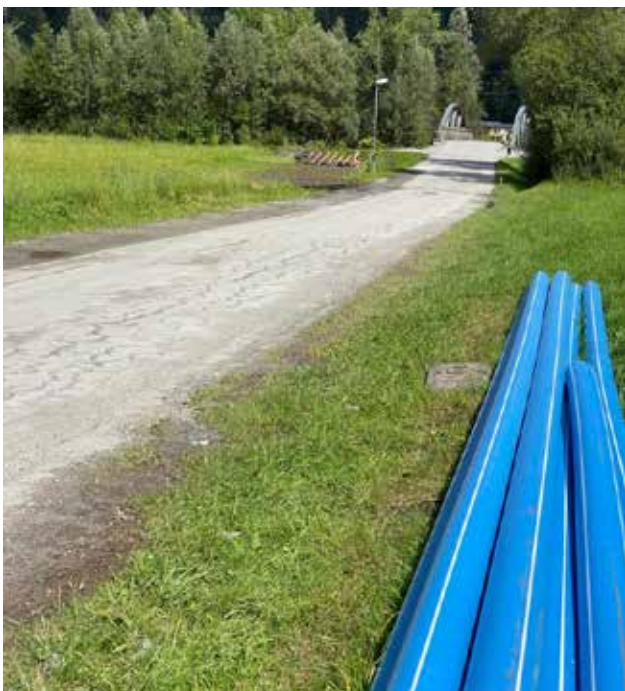
Neuerlegung der Wasserleitung in St. Georgen
