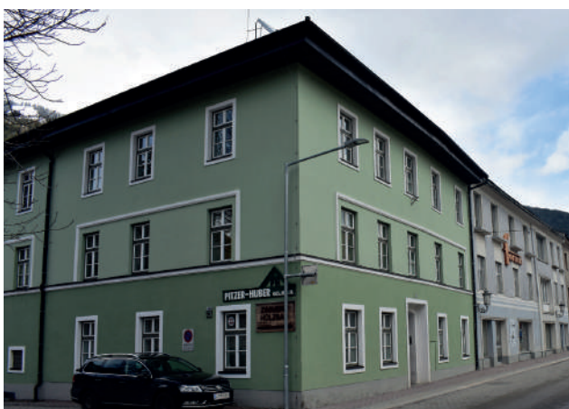
Der mächtige Gebäudekomplex des Färberhauses umfasste die heutigen Objekte Hauptstraße 69 und 70
