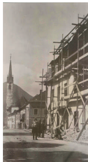
Umbau des westlichen Hauses durch Eduard Pitzer 1931
