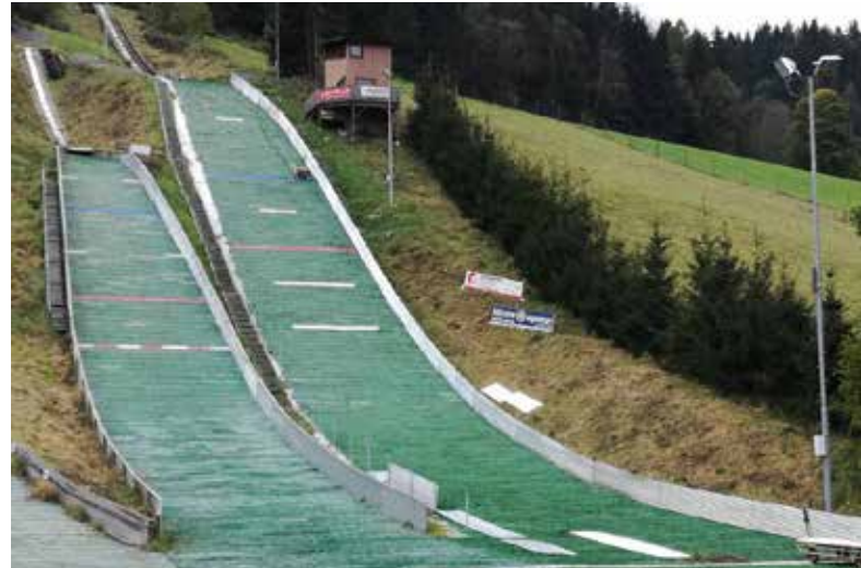
Die K44 Schanze kurz vor der Fertigstellung
